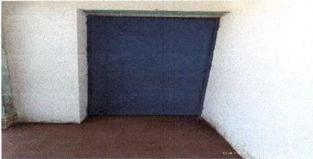
Foto 13: Sustrucción de puertas de metal en modulo de cocina
