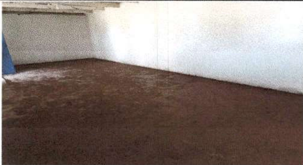
Foto 5: Sustitución de piso por piso de torta de concreto en modulo de cocina
