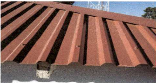
Foto 3: Sustitucion de elementos de fijacion en modulo de cocina
