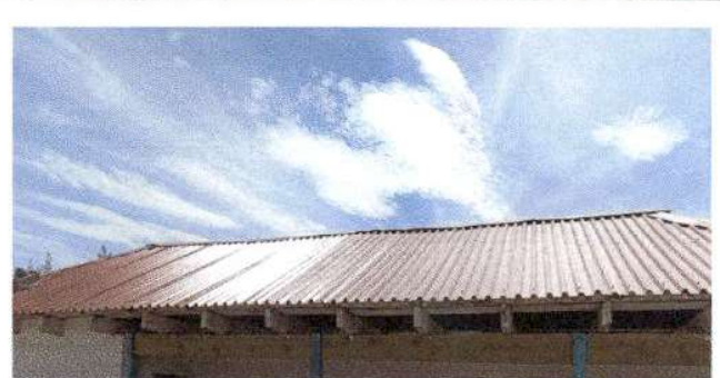
Foto 2: Sustitucion total de capote de lamina para lamina troquelada en modulo de cocina
