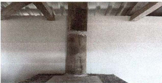
Foto 17: Sustrucción de chimenea de concreto en modulo de cocina
