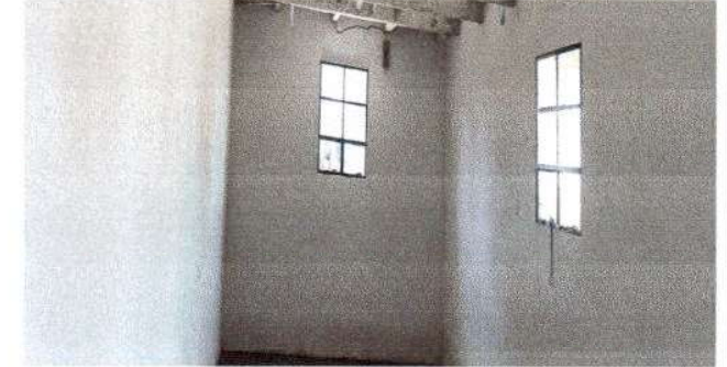
Foto 4: Sustitucion de ventana de madera por metal mas vidrio en modulo de cocina
