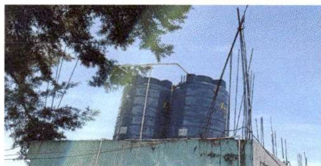
Foto 12: Sustrucción de deposito de agua 1250 Lts en modulo de baños
