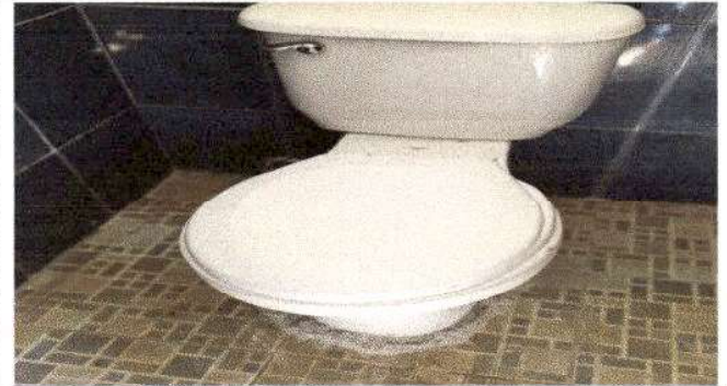
Foto 14: Instalacion de inodoro en modulo de baños
