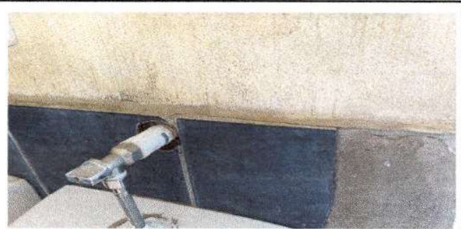
Foto 6: Sustitucion de llaves de migintorio en modulo de baño
