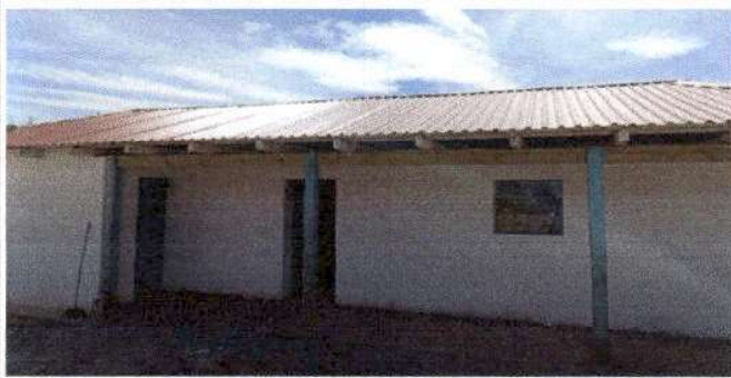
Foto1: Sustitucion de lamina por lamina troquelada aluzinc calibre 26 en modulo de cocina
