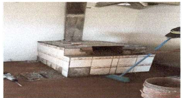
Foto 16: Sustrucción Plancha de metal de 3 hornillas en modulo de cocina
