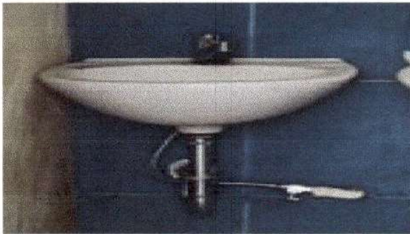
Foto 15: Instalación de llaves de lavamanos en modulo de baños
