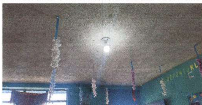
Foto 7: Sustrucción de focos ahorradores en modulo de aula
