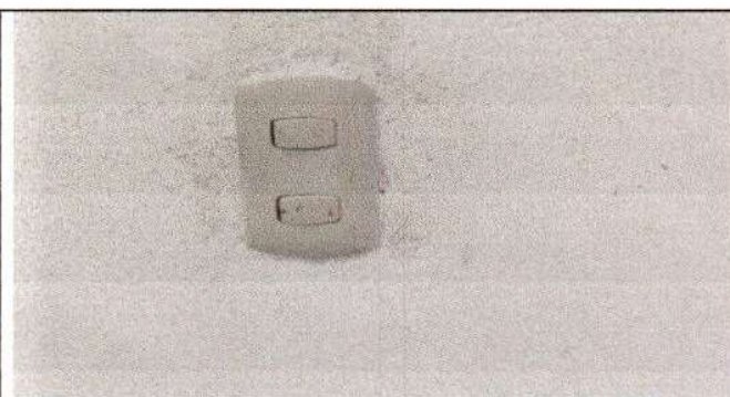
Foto 9: Sustrucciones de inerruptores simples en modulo de cocina
